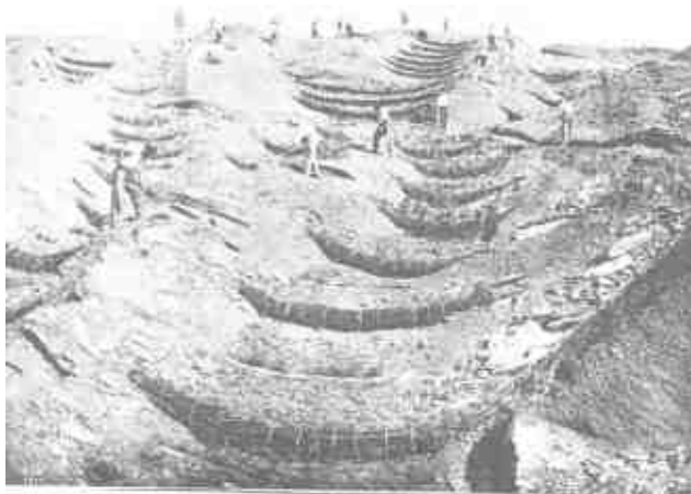
Pose de fascines ou clayonnages dans un ravin
