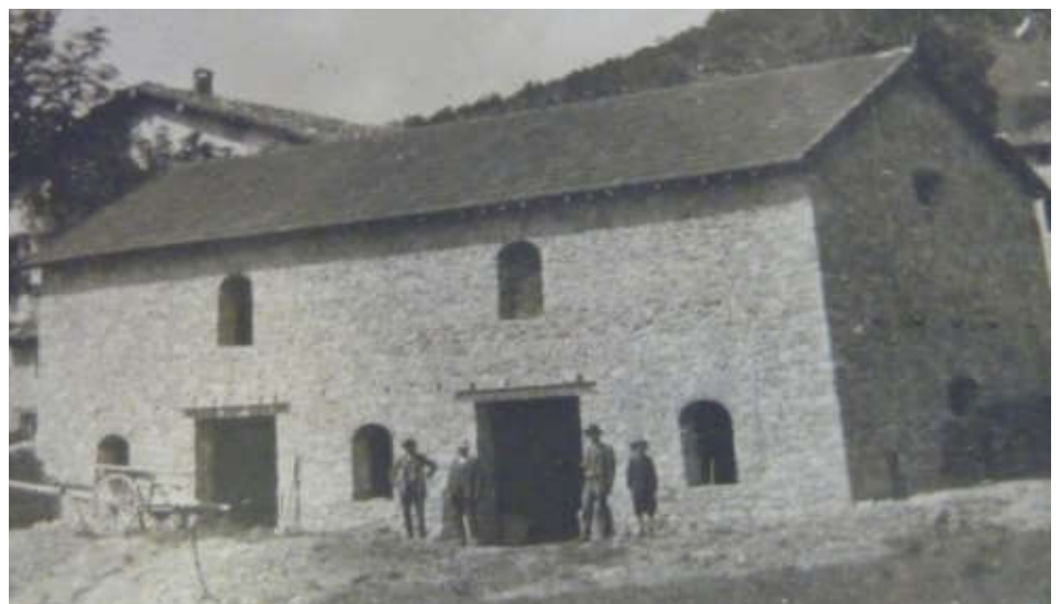
Photo de la bergerie en fin de construction du gros œuvre avec à droite Olivier Bouillanne et son fils René 13
